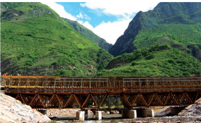
Tingo zubia eraikitzeko fase guztietan MK sistema, BRIO aldamioa eta NEVI enkofratzeko sistema erabili ziren, baita 2000 Kontsola Igoariak ere
