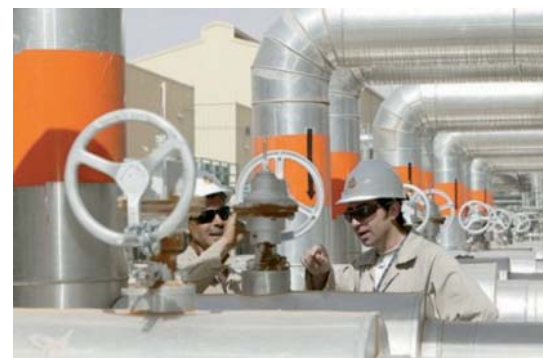
Gasaren garraiatzeko instalazioak egiazatu eta probatzeko fasean, ondoren martxan jartzeko.
