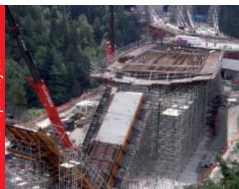
ULMA Construcción-ek Dels 2 Valires tunelerako sarbideetan lankidetzan jardun du Andorran
