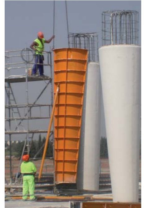
Pilare tronkokoaren desenkofratua.
