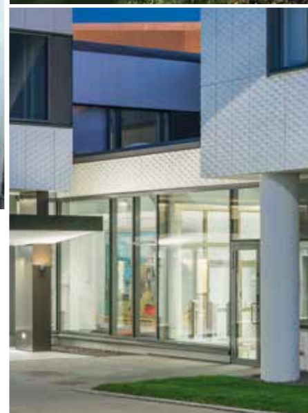
> ALBISTEAK ETA GAURKOTASUNA Fatxada aireztatua 3D CREAKTIVE testura berritzaile batekin Finlandian
