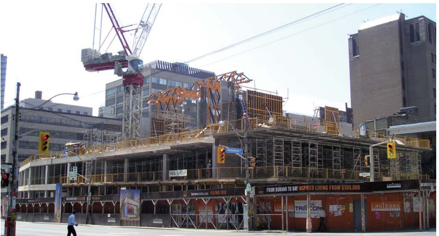
Burano etxe orratzeko lehenengo solairuak egiteko prozesua, Kanada
