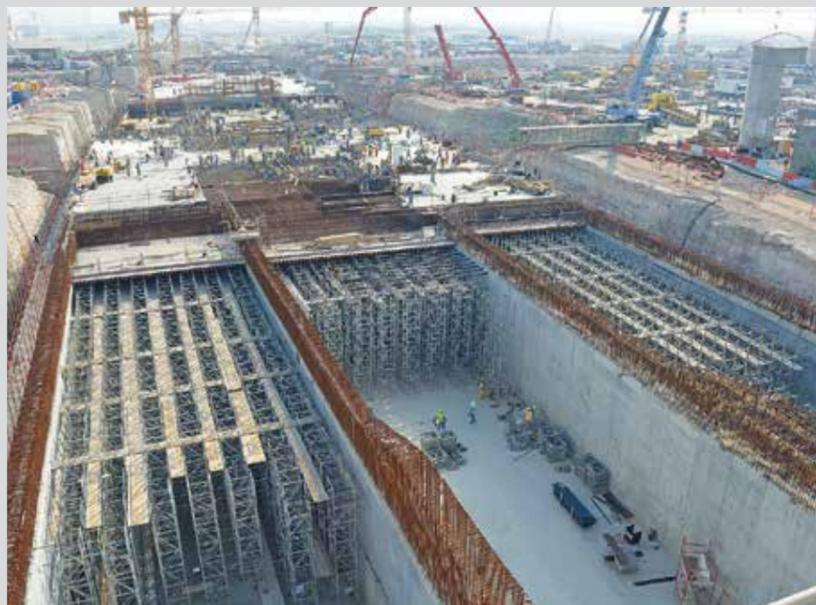
UN TÚNEL A CIELO ABIERTO DE 655 M DE LONGITUD Y 45 M DE ANCHURA CON LOS TRES HUECOS. EL HUECO CENTRAL DESTINADO AL TRÁFICO FERROVIARIO CON DOS LÍNEAS EN CADA DIRECCIÓN.
