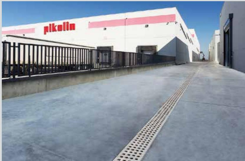
con orificios más reducidos y superficie lisa para evitar vibraciones ante el paso de carretillas.
