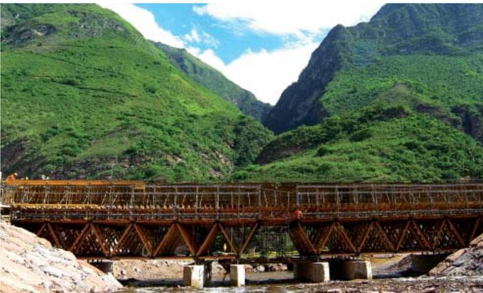
En todas las fases de construcción del Puente Tingo se empleó el sistema MK, andamio BRIO y el sistema de encofrado NEVI, así como las Consolas de Trepado 2000
