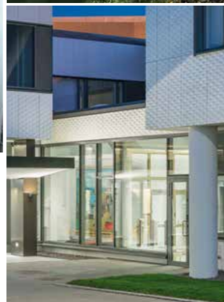
> NOTICIAS Y ACTUALIDAD Fachada Ventilada con una innovadora textura CREAKTIVE 3D en Finlandia
