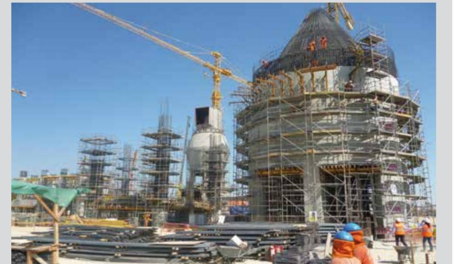
cilíndricos y de fácil montaje, no sólo han soportado los paneles COMAIN, como encofrado del anillo, sino que han creado un nivel donde colocar plataformas de trabajo para labores de ferrallado y encofrado.
