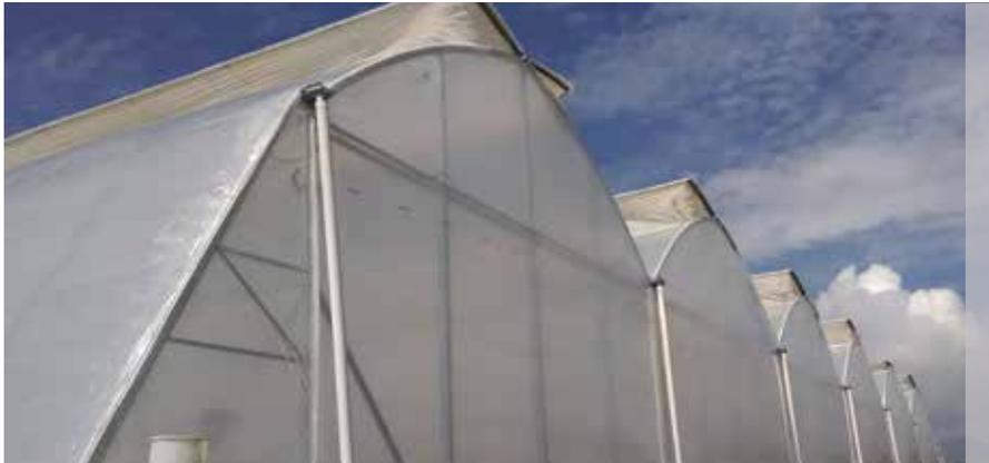
Entre las bondades del modelo G12 de ULMA Agrícola destaca el ancho de nave de 12,8 metros maximizando el espacio interior aprovechable del invernadero. La mayor distancia entre pilares se compensa por la robustez que le confiere el empleo del perfil oval de 90 mm en los arcos, optimizando el equilibrio entre volumen y resistencia.
