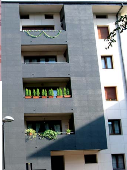
NOTICIAS Y ACTUALIDAD. Solución de problemas de humedades e importante mejora de imagen rehabilitando la fachada con ULMA Architectural Solutions
