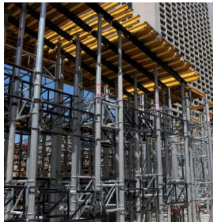
Ejecución de losas con ENKOFLEX en el rascacielos Living Shangri-la
