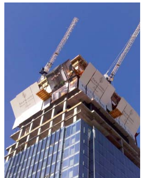
Empleo de Protección Perimetral autotrepante HWS en el rascacielos Four Seasons en Canadá
