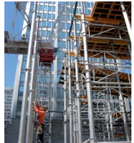
Ejecución de losas con CC-4 en el rascacielos Living Shangri-la
