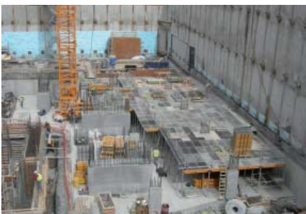
Ejecución de losas con CC-4 en Aura Tower, Ontario, Canadá
