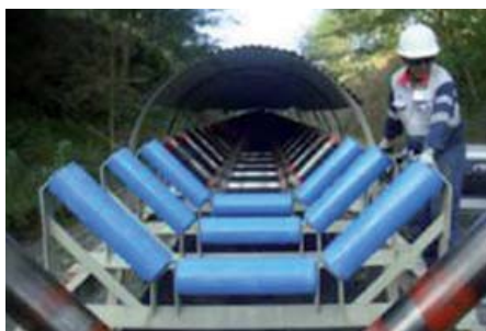
Imagen PT Newmont. Instalación de los rodillos UCC en el transportador de 6 km que conecta la mina con la planta de tratamiento.
